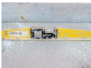
Vue du radier réalisé plat de niveau
