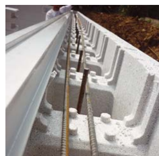
Détail bloc et ferrailage du rang supérieur
