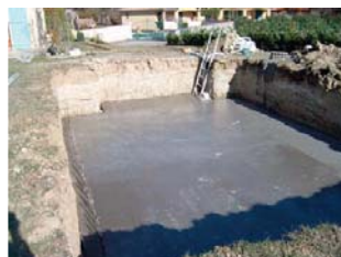
Vue du radier réalisé plat de niveau
